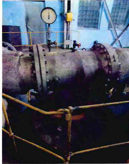
Фото 2.2. – ПСВ№3 установлен и включен в работу.
