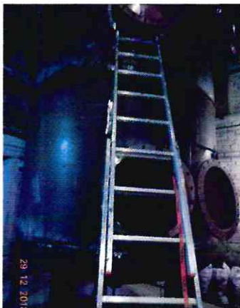
Фото 6.1. – Монтаж механического фильтра №4
