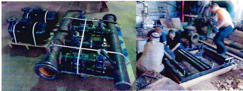
Фото 7.1., 7.2 - Монтаж насосной станции ХВО.
