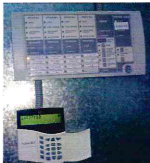
Фото 5.8., 5.9. – система пожарной сигнализации
