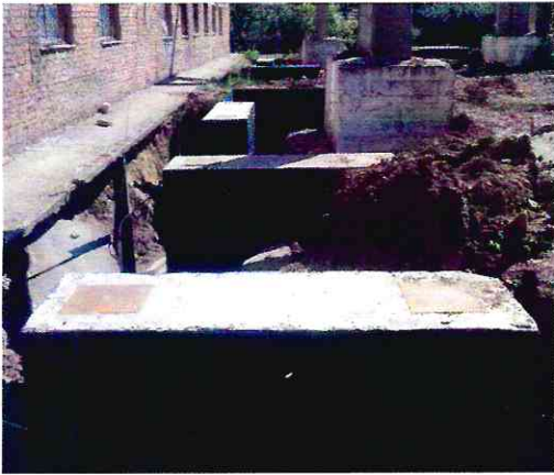
Фото 4.1.- Фундамент для газоходов и газотводящего ствола
