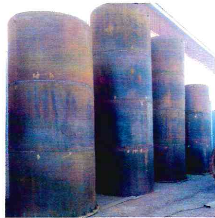
Фото 4.2. – Детали газотводящего ствола
