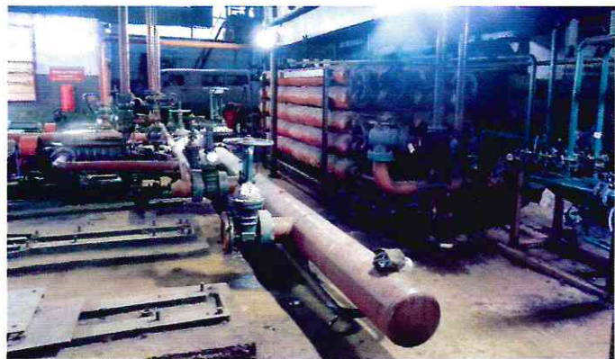
Фото 5.1., 5.2. - Перевод технологии подогрева мазута с пара на горячую воду.
