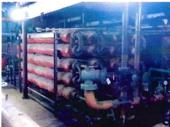
Фото 5.1., 5.2. - Перевод технологии подогрева мазута с пара на горячую воду.
