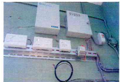
Фото 5.8., 5.9. – система пожарной сигнализации
