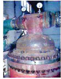
Фото 1.2. Трубная система ПСВ№4. 1.3.- Установлен и включен в работу
