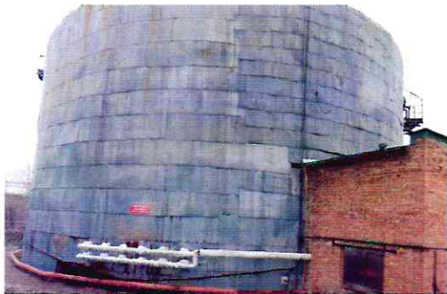
Фото 5.7. – Мазутохранилище объемом 5000 м 3 .
